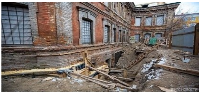
г. Красноярск, реставрируемое здание;
